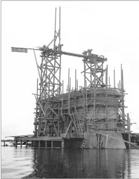
Строящаяся опора у Городища. Снимок П.П. Покрышкина. 1917 г.
