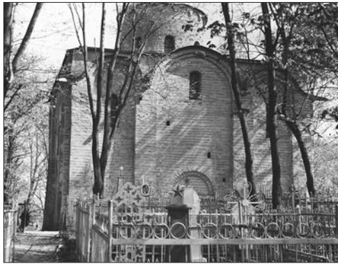
Церковь Петра и Павла на Сильнице. Вид после реставрации
