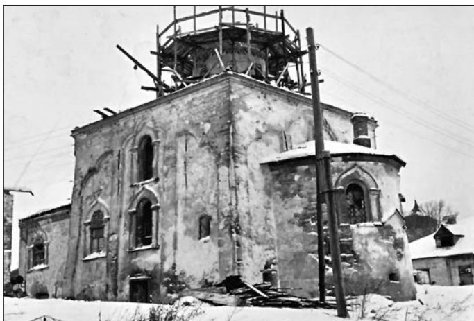
Церковь Николая Белого. Вид до реставрации
