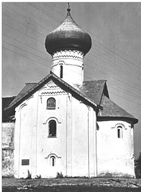
Церковь Симеона Богоприимца. Вид после реставрации
