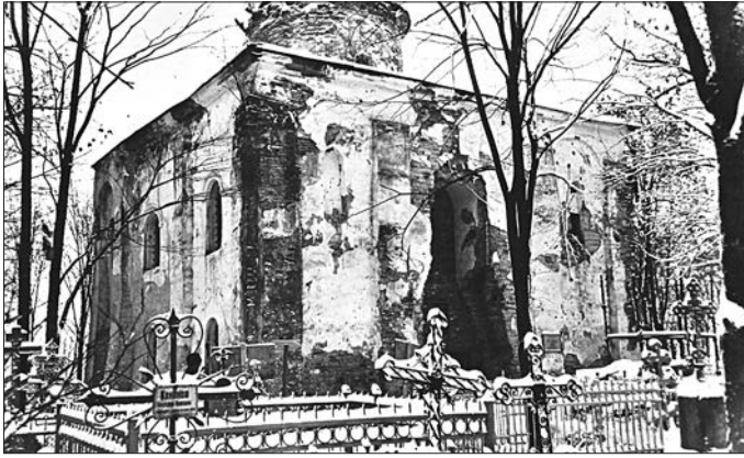
Церковь Петра и Павла на Сильнице. Вид до реставрации
