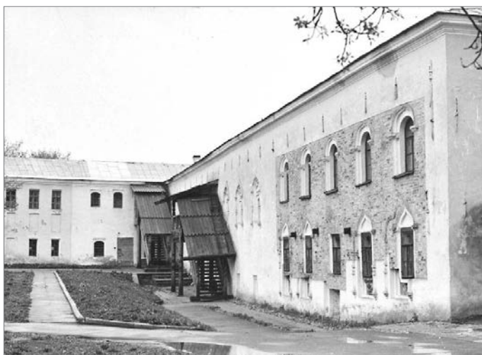
Никитский корпус Новгородского кремля. Юго-западный угол. 1970-е гг. Из архива Г.М. Штендера. НГМ КП 40585/902 Ф. Р-15. Оп. 2. Ед. хр. 276
